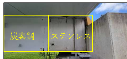
写真1 桁端部にステンレスを使用した鋼橋
