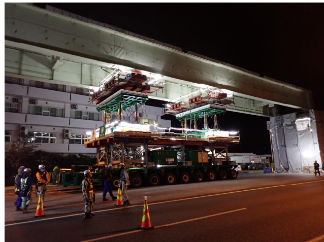
写真-2 多軸台車で桁のリフトアップ状況
