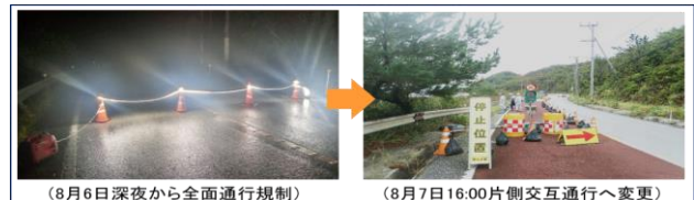
図-4 県道70号線の規制状況
