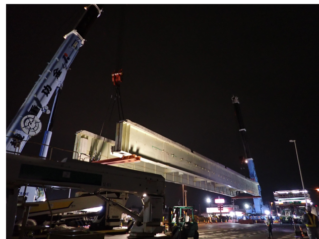
写真-4 多軸台車からの桁の荷卸し状況
