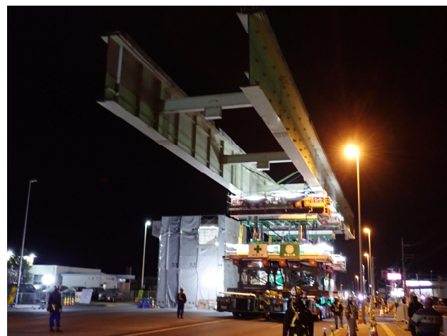
写真-3 多軸台車走行状況
