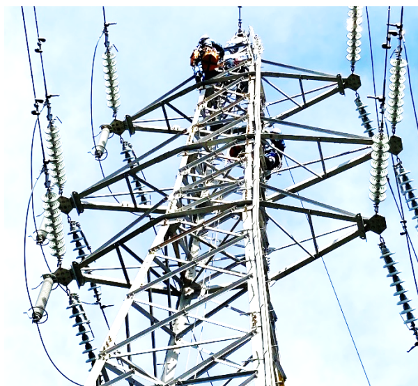
b) 塔上での施工状況
