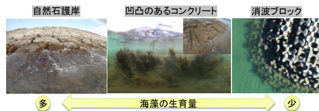
写真-4 護岸の素材・形状による海藻生育量の違い
