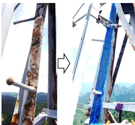
図-13 部材 No④の施工前後写真
